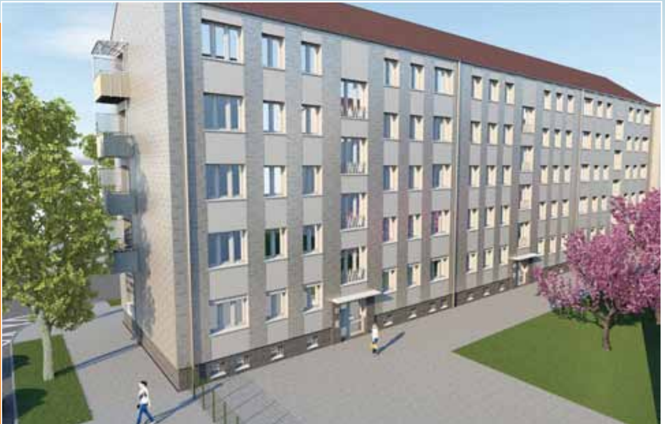
Charlottenburger Straße 18, 18a, 19 – Ansicht der Hofseite nach der Sanierung
