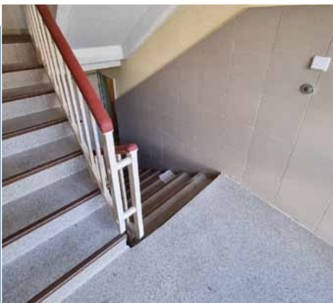
Treppenhaus Bernkasteler Straße 71
