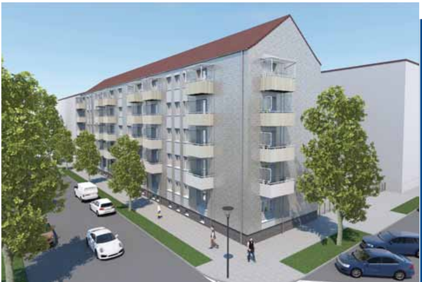
Charlottenburger Straße 18, 18a, 19 – Ansicht der Straßenseite nach der Sanierung
