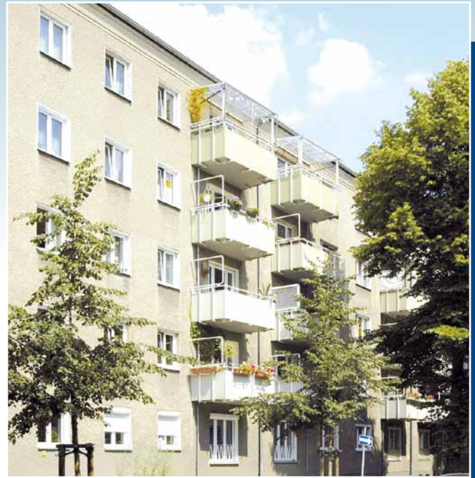
Charlottenburger Straße 18, 18 a und 19 vor der Sanierung
